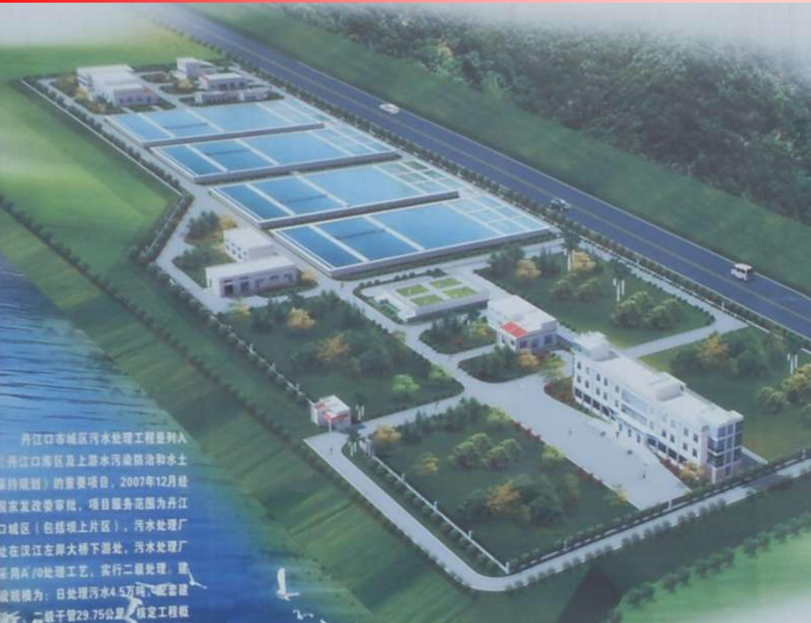
丹江口市城区污水处理工程是列入《丹江口库区及上游水污染防治和水土保持规划》的重要项目，2007年12月经国家发改委审批，项目服务范围为丹江口城区（包括坝上片区）。污水处理厂址在汉江左岸大桥下游处。污水处理厂采用A<sup>2</sup>/O处理工艺，实行二级处理。建设规模为：日处理污水4.5万吨，配套建设一级、二级干管29.75公里。核定工程概
